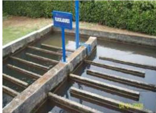
Fotografía 7. Vista floculadores hidráulicos
