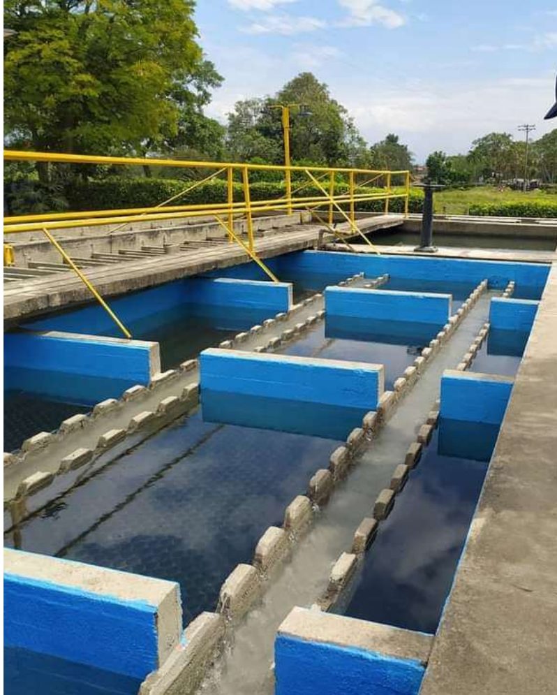
Fotografía 8. Sedimentador tipo colmena
