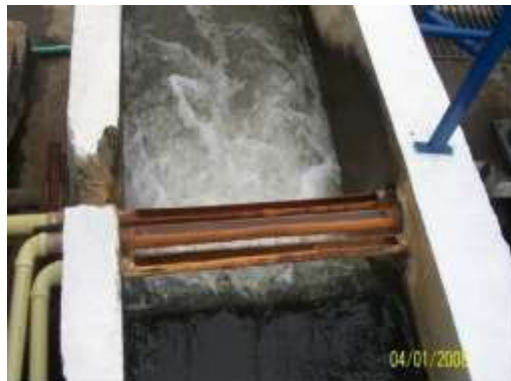
Fotografía 6 Mezcla rápida
